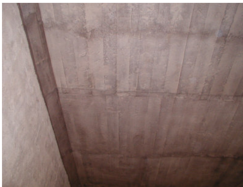
Abb. 4: Betondecke nach einmaliger Spachtelung mit Epoxidharzspachtel
