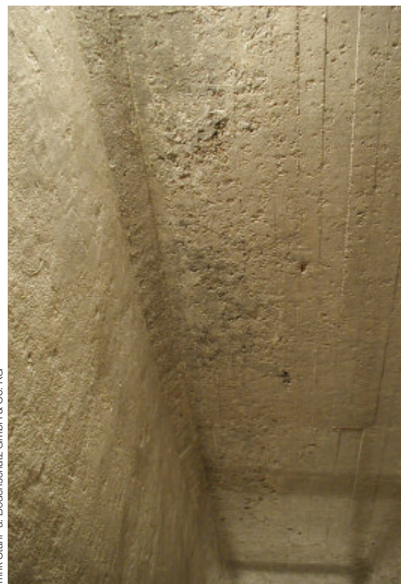
Abb. 2: Behälterflächen nach dem Strahlen
