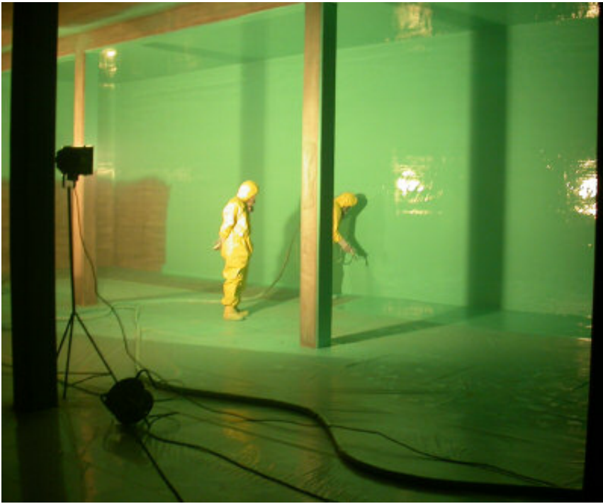
Abb. 5: Applikation von lösemittelfreier Epoxidharzbeschichtung im Heißspritzverfahren
